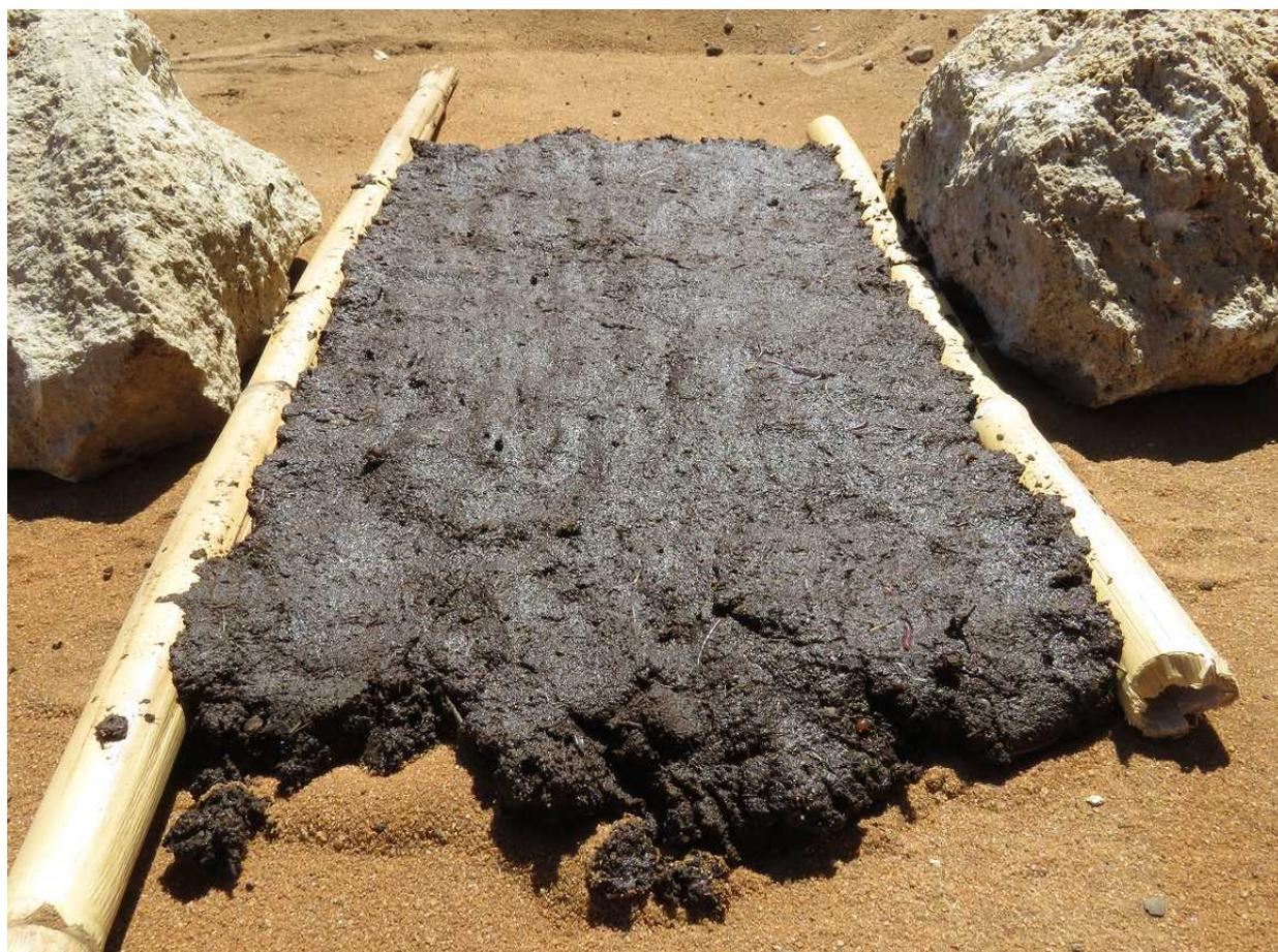
Coupez les bordures si nécessaire pour le rendre droit. Le reste peut être remis avec le mélange à utiliser pour les cubes suivants.
